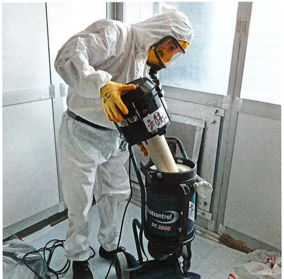
Travaux dans une zone de désamiantage. // Suva
